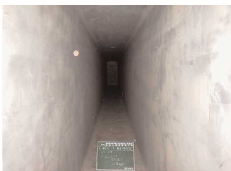
素地調整完了
