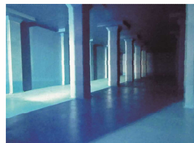
池内防食完了
