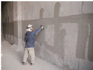
防食下地処理状況
