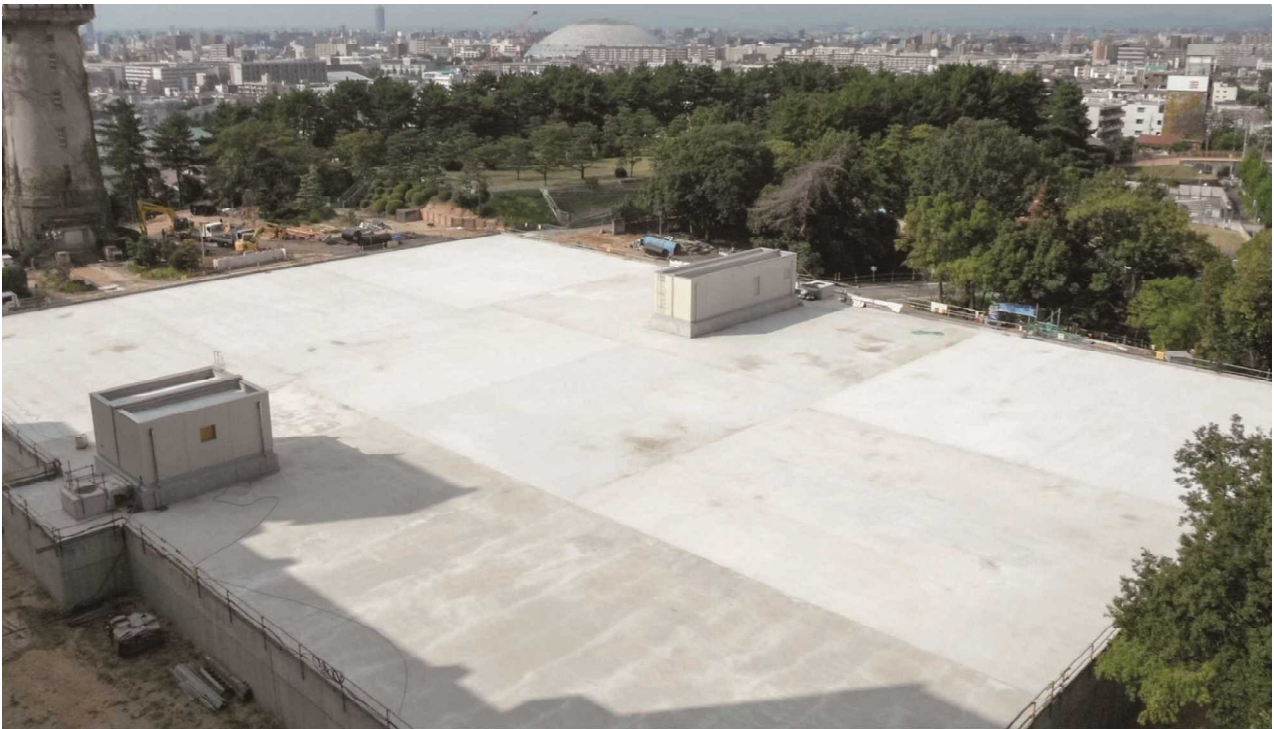
構築完了全景
