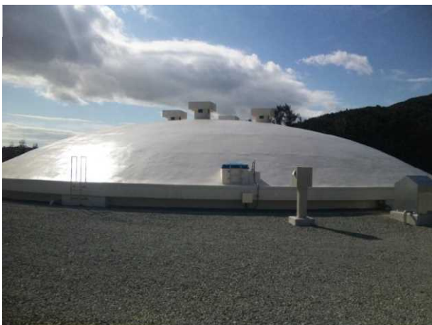
【福島県郡山市】 堀口浄水場
