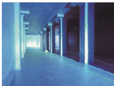
池内防食完了
