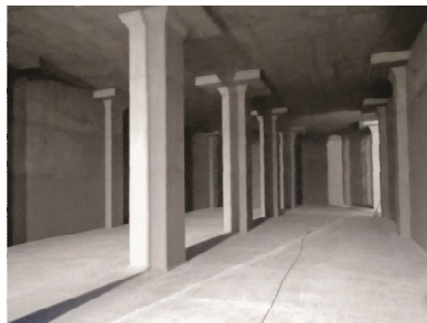
防食下地完了
