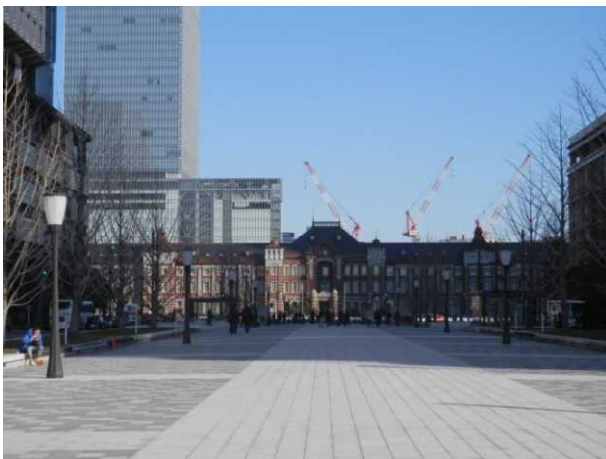
【東京都】 東京駅丸の内駅舎保存復元
