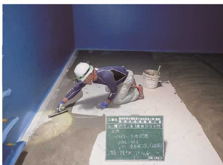
素地調整①ポリマーセメント
