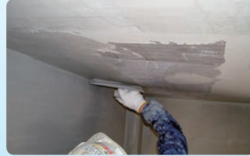
②ポリマーセメントモルタル塗布
